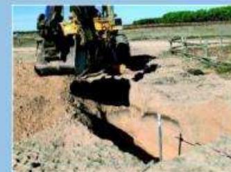
Detalle del aspecto que presenta el humidímetro, una vez que está colocado.
